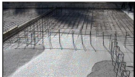
Figure 3. Coulage multi-couches (image tiré du chantier expérimental du projet National Béton Autoplaçants). La dernière coulée (plus claire) recouvre, au centre, la coulée précédente (plus sombre).
